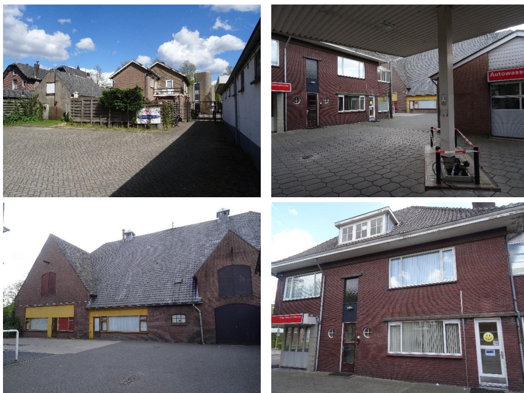
Indrukken van de onderzochte gebouwen binnen het plangebied aan de Engweg 8 – 14 te Driebergen (foto's Laneco)
