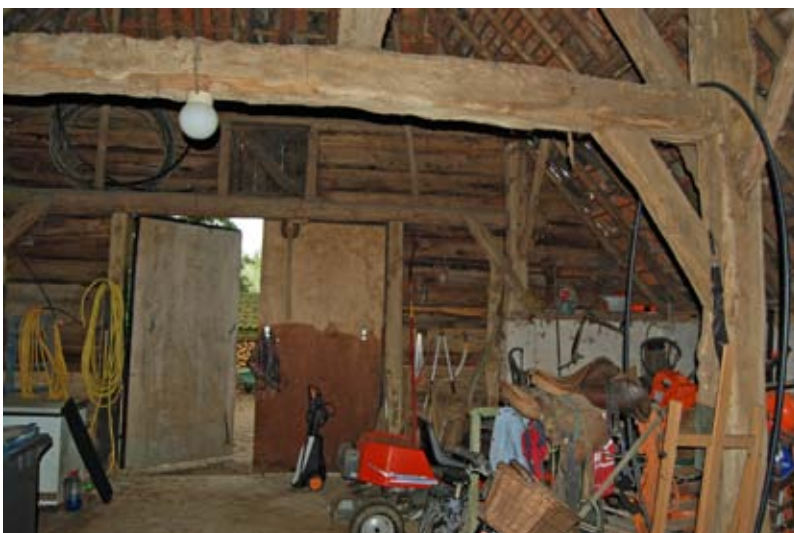
Afb. 3.9. Overzicht van het interieur van de schaapskooi grenzend aan de noord-oostelijke gevel.
