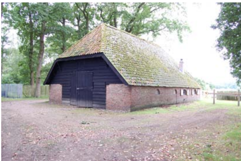
Afb. 3.3. Extérieur vanuit het noorden.
