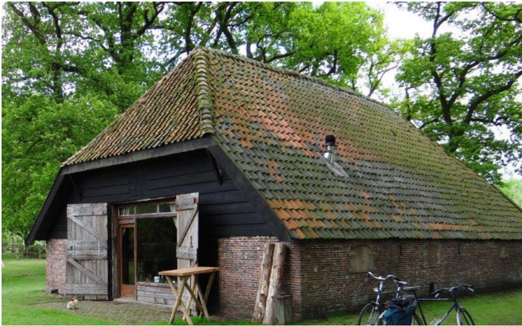
Foto 7. De Schaapskooi: bestaande situatie. Zicht op de “west- en noordzijde”.
