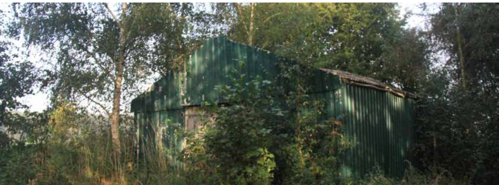
Afbeelding 5. De vervallen veldschuur aan de zuidkant, net buiten het plangebied.
