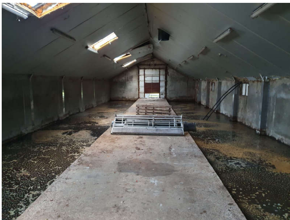
Figuur 2 De veestal is opgetrokken uit gemetselde muren en draagt een golfplaten dak dat aan de binnenzijde is geïsoleerd.
