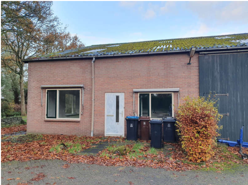
Figuur 4 De schuur is opgetrokken uit gemetselde muren en draagt een golfplaten dak.
