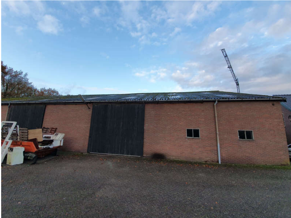
Figuur 3 Op het perceel aan de Parallelweg 4/4a wordt een deel van een schuur gesaneerd.
