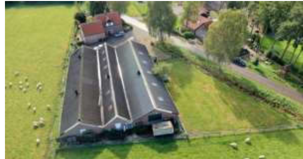
Figuur 13: Asbestverdachte golfplaten
