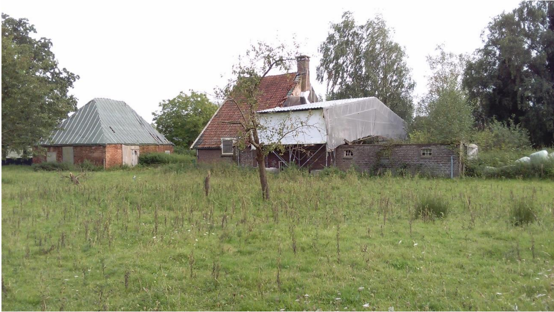
Afbeelding 8: Foto bestaande situatie afgebrande boerderij en links daarvan de schuur
