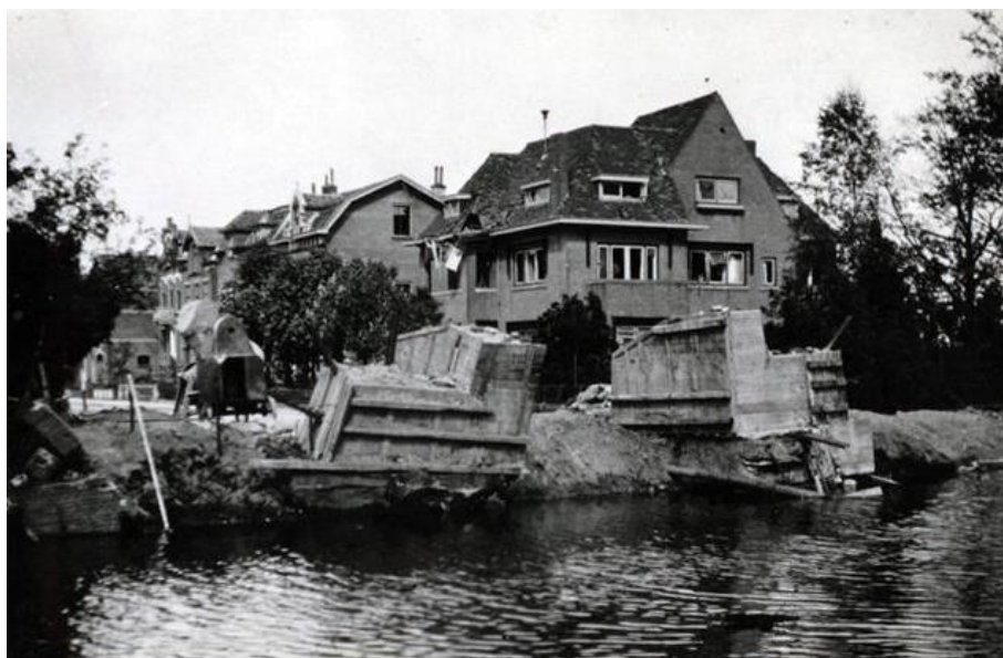
Figuur 15. Vernielde Vaartbrug over het Omleidingskanaal t.h.v. Kerkewijk
