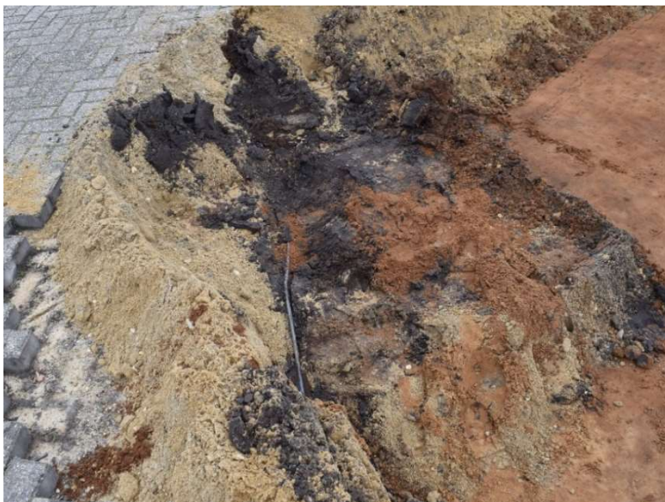
Afbeelding 6: Eén van de kabels in werkput 4 waardoor de bodem verstoord is geraakt. Foto genomen richting het zuidoosten. Bron: Vestigia.
