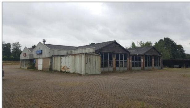
Afbeelding 2.4 | Zicht vanaf noordwest op de garage.
