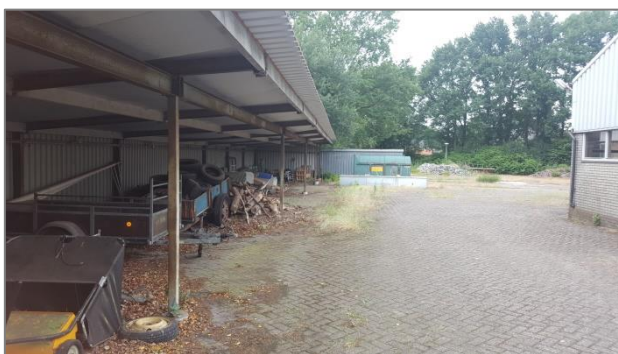
Afbeelding 2.5 | De fietsenstalling/opbergruimte met materiaal.
