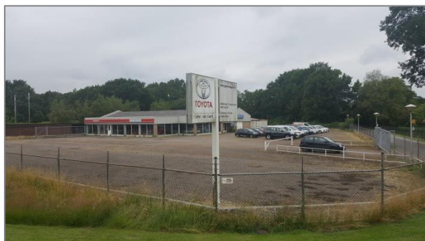
Afbeelding 2.1 | Zicht vanaf de Slaperdijk
