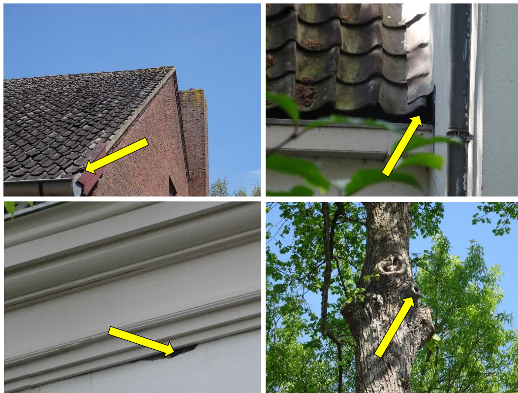
Enkele voor vleermuizen geschikte openingen in de bebouwing binnen het plangebied (boven en linksonder) en voor vleermuizen potentieel geschikte holtes (rechtsonder) (foto's: Laneco).
