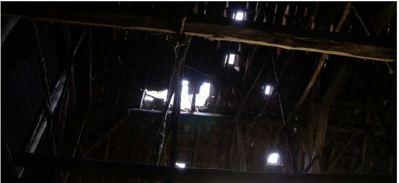
Afbeelding 3: Detailfoto van het dak van de tabaksschuur (van binnen uit genomen) met de aanwezige gaten in dit dak.
