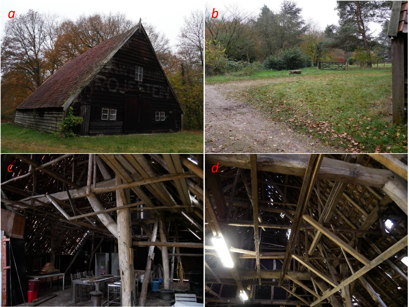
Afbeelding 2: een impressie van het plangebied met de buitenkant van de tabaksschuur vanuit de oostzijde gezien(a), het aangrenzende grasveld (b), de binnenkant van de schuur (c) en een detailbeeld van de spantconstructie (d).
