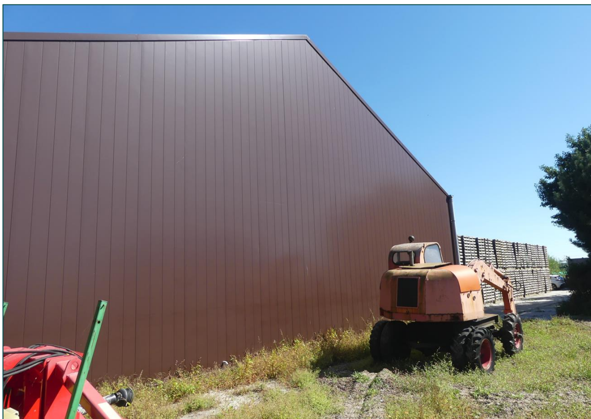
Figuur 1 Een van de loodsen waar tegenaan gebouwd gaat worden.
