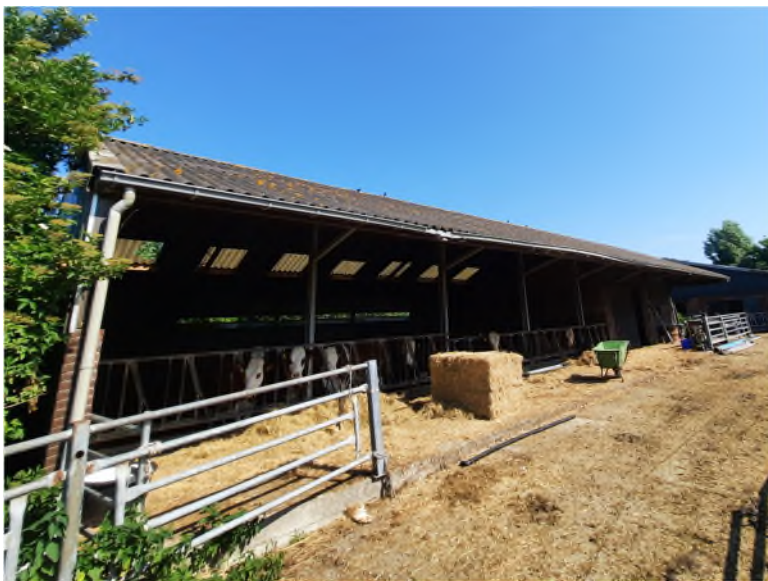
Figuur 3.1: Betreffende stal met huismusnesten waarbij de asbestgolfplaten zichtbaar zijn
