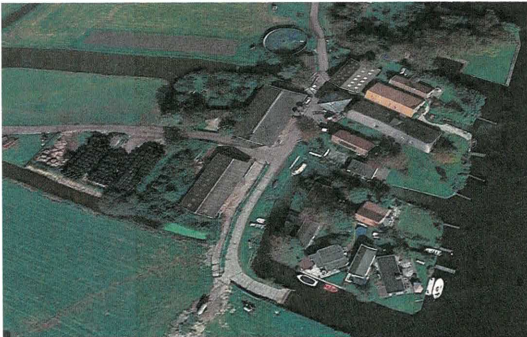
Luchtfoto locatie Zwanburgerpolder 6 te Warmond. Bron: Google earth d.d. 15-9-2020
