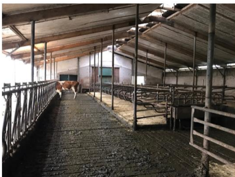
Drijfmestkelder met roostervloer
