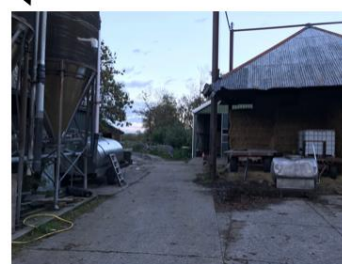
Krappe doorgang koeienstal en hooiberg
