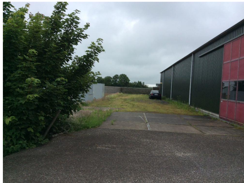
Stelconplaten op de locatie
