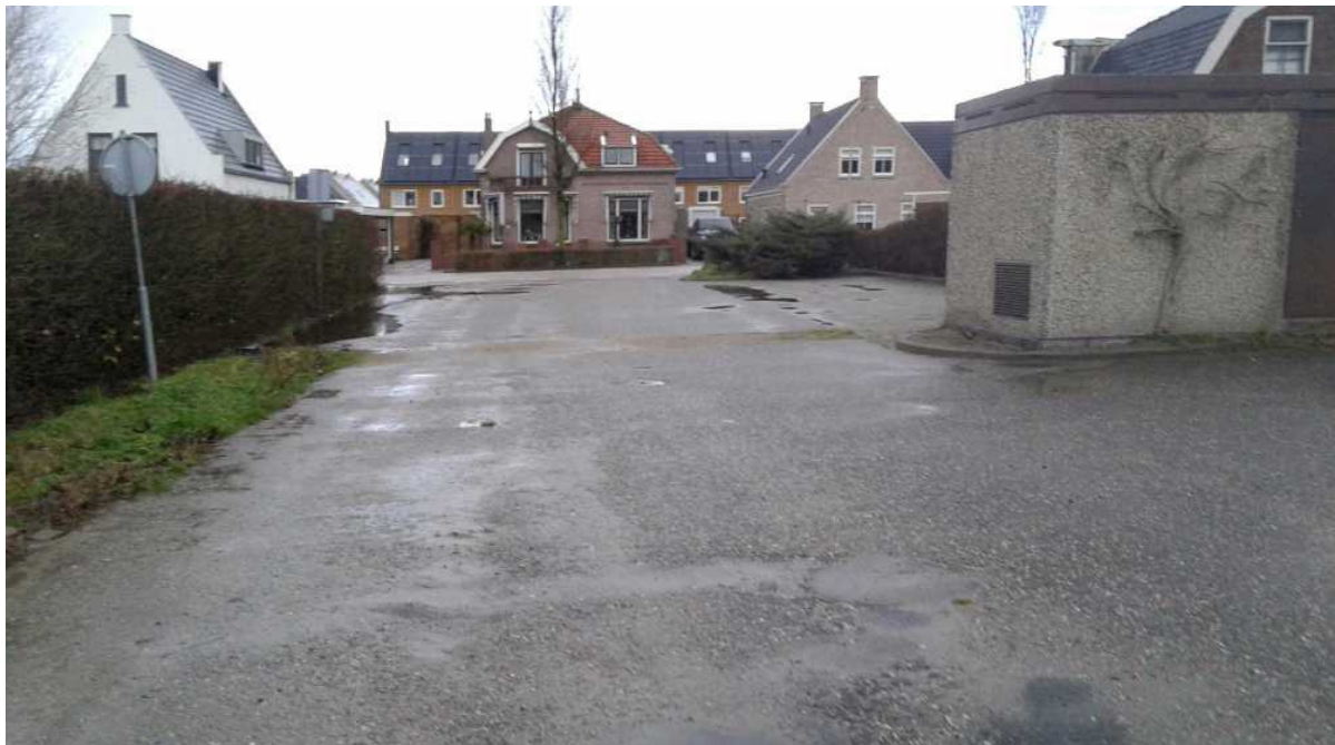
Foto 1: gedeelte asfaltverharding, rechts het trafohuisje met links daarvan een van de opgebroken stroken
