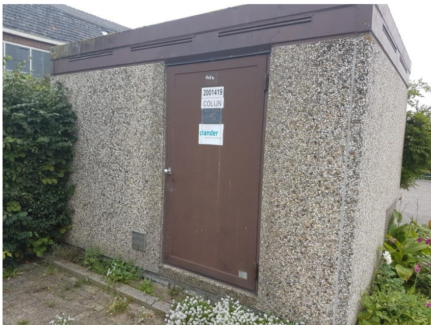
Figuur 1: Foto transformatorhuis
