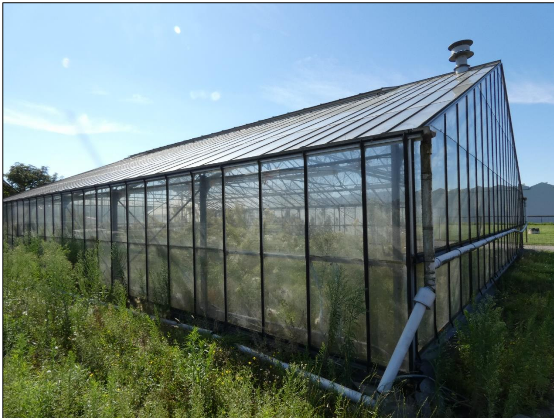
Figuur 9: Eén van de twee glazen kassen. De kassen bieden geen potentie voor beschermde soorten zoals huismussen, gierzwaluwen of vleermuizen. Echter kan een rugstreeppad via de gebroken ruiten toegang verkrijgen tot de kas om hierin te verblijven.
