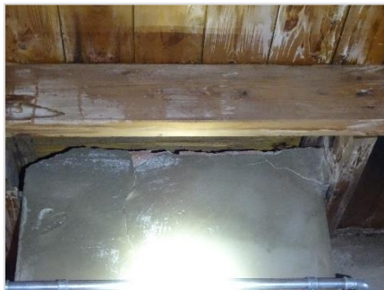
Foto 39: Geen openingen bij dakrand/zoldering.
