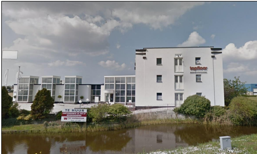
Aanzicht van het pand vanaf de Loosterweg 3-5. De locatie waarbinnen de woningen worden voorzien betreft het rechter gebouw.
