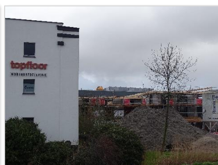
Foto 9: Plangebied (nieuwbouwproject in uitvoering aan noordoostzijde).
