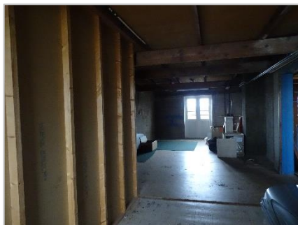
Foto 27: Bovenste etage waar appartementen gepland zijn.
