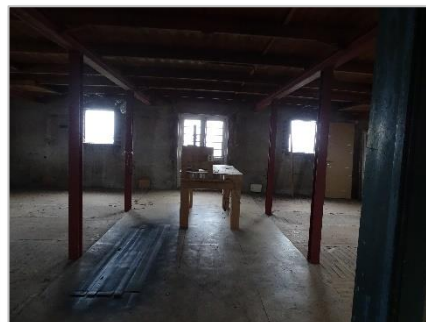
Foto 28: Bovenste etage waar appartementen gepland zijn.
