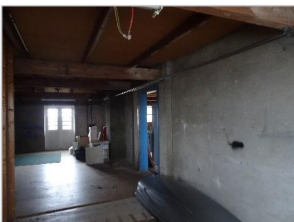
Foto 29: Bovenste etage waar appartementen gepland zijn.
