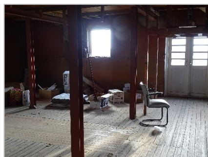
Foto 34: Bovenste etage waar appartementen gepland zijn.
