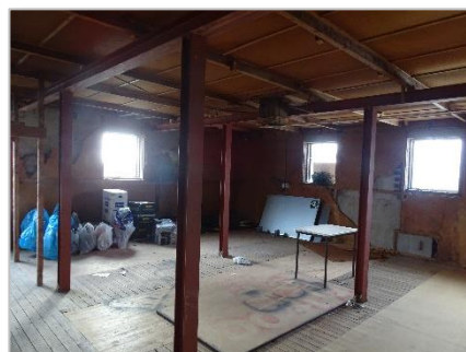
Foto 31: Bovenste etage waar appartementen gepland zijn.
