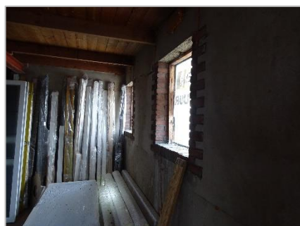
Foto 33: Bovenste etage waar appartementen gepland zijn.
