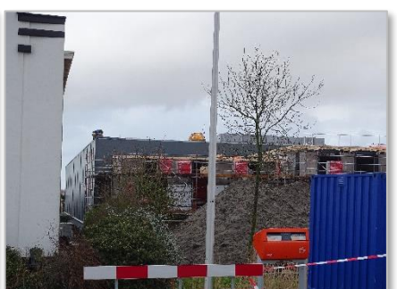
Foto 10: Plangebied (nieuwbouwproject in uitvoering aan noordoostzijde).
