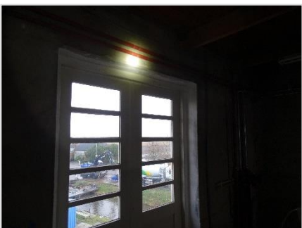
Foto 48: Geen openingen bij gevels/kozijnen.
