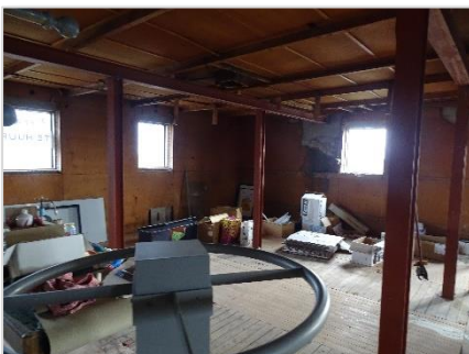
Foto 30: Bovenste etage waar appartementen gepland zijn.
