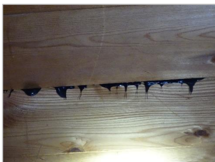
Foto 41: Geen openingen bij dakrand/zoldering.
