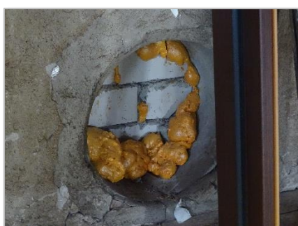
Foto 45: Geen openingen bij gevels/kozijnen.
