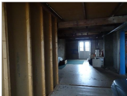
Foto 27: Bovenste etage waar appartementen gepland zijn.
