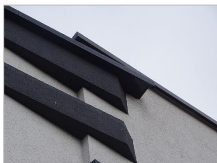
Foto 17: Gevel/dakrand oude bollenschuur (geen openingen, stoorvoegen, ventilatiegaten o.i.d.).
