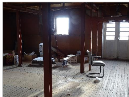
Foto 34: Bovenste etage waar appartementen gepland zijn.
