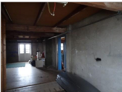
Foto 29: Bovenste etage waar appartementen gepland zijn.
