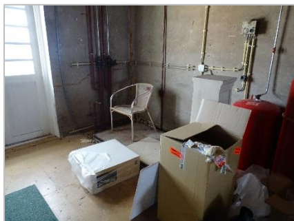
Foto 32: Bovenste etage waar appartementen gepland zijn.
