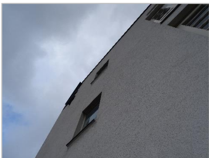
Foto 25: Gevel oude bollenschuur (geen openingen, bij ramen, deuren of kozijnen).
