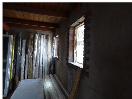
Foto 33: Bovenste etage waar appartementen gepland zijn.
