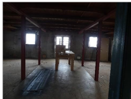
Foto 28: Bovenste etage waar appartementen gepland zijn.
