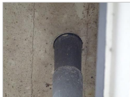
Foto 20: Gevel oude bollenschuur (geen openingen, bij aansluiting regenpijpen).
