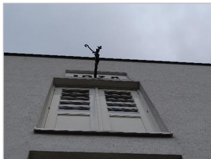
Foto 22: Gevel oude bollenschuur (geen openingen, bij ramen, deuren of kozijnen).
