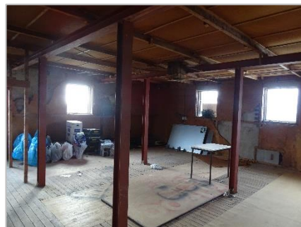
Foto 31: Bovenste etage waar appartementen gepland zijn.
