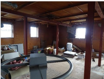
Foto 30: Bovenste etage waar appartementen gepland zijn.
