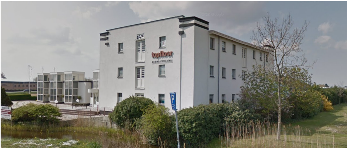
Figuur 4 – Bestaande toestand
