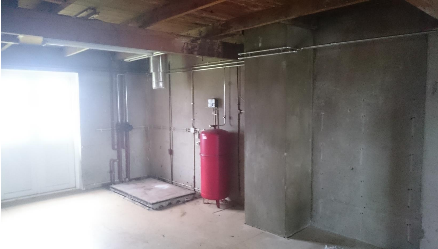
2 e verdieping Opstorting vloer, bestaand schoorsteen kanaal
