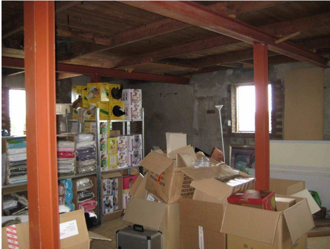
2 e verdieping Balklaag, stalen liggers en kolommen
