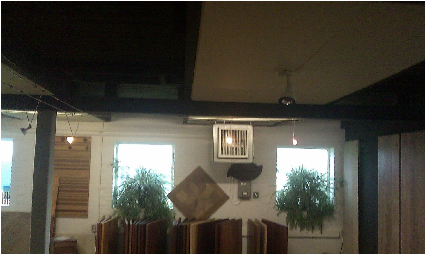
1 e verdieping Stalen liggers en kolommen (winkel)
