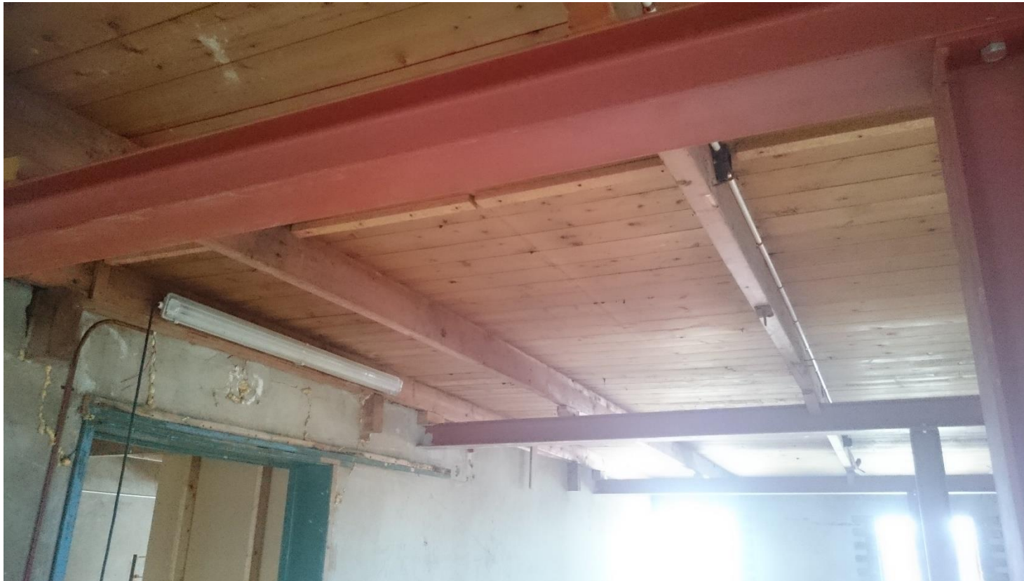
2 e verdieping Balklaag, stalen liggers en kolommen
