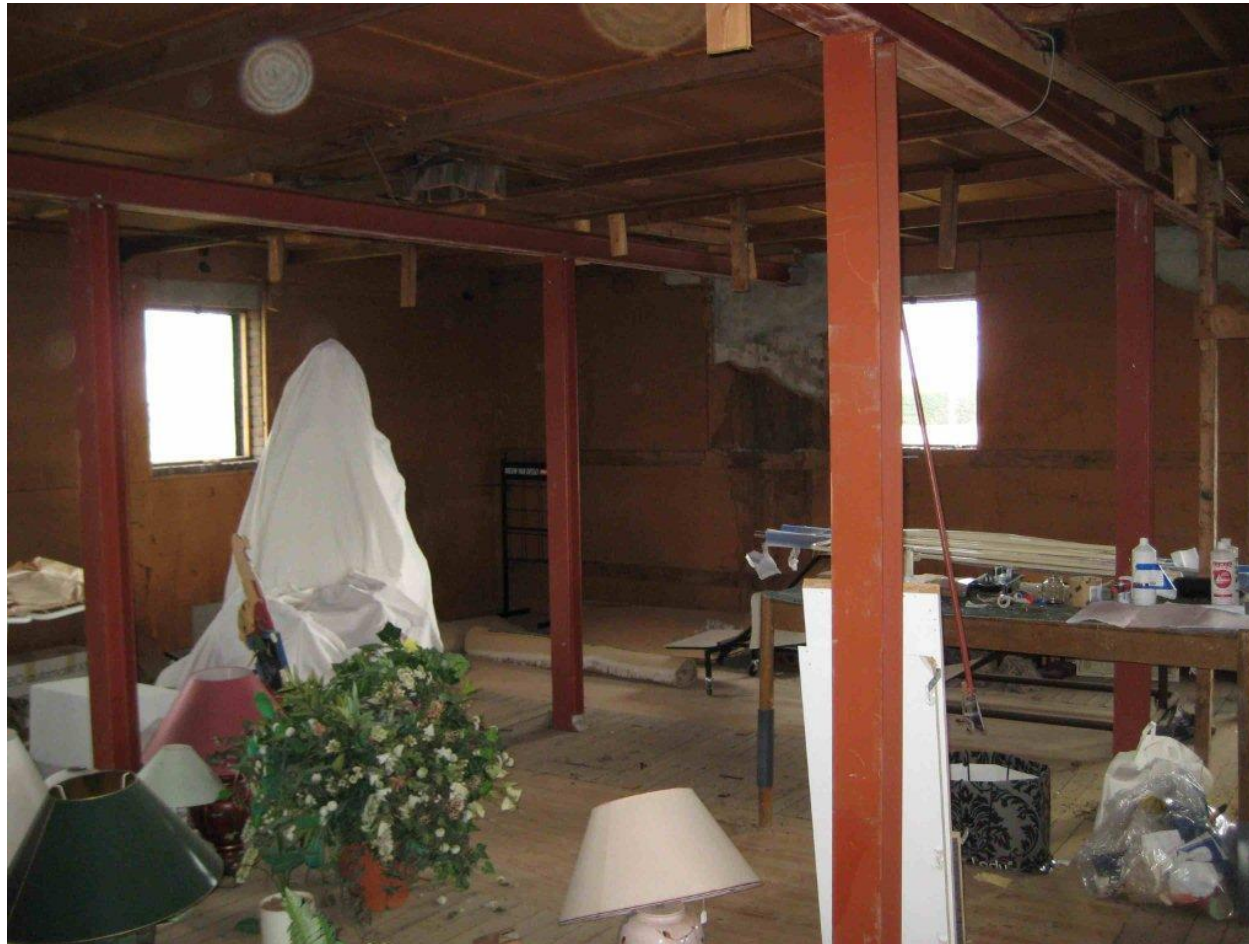
2 e verdieping Balklaag, stalen liggers en kolommen
