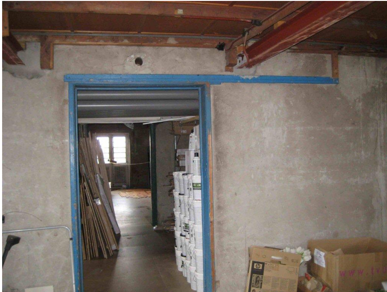
2 e verdieping Doorgang
