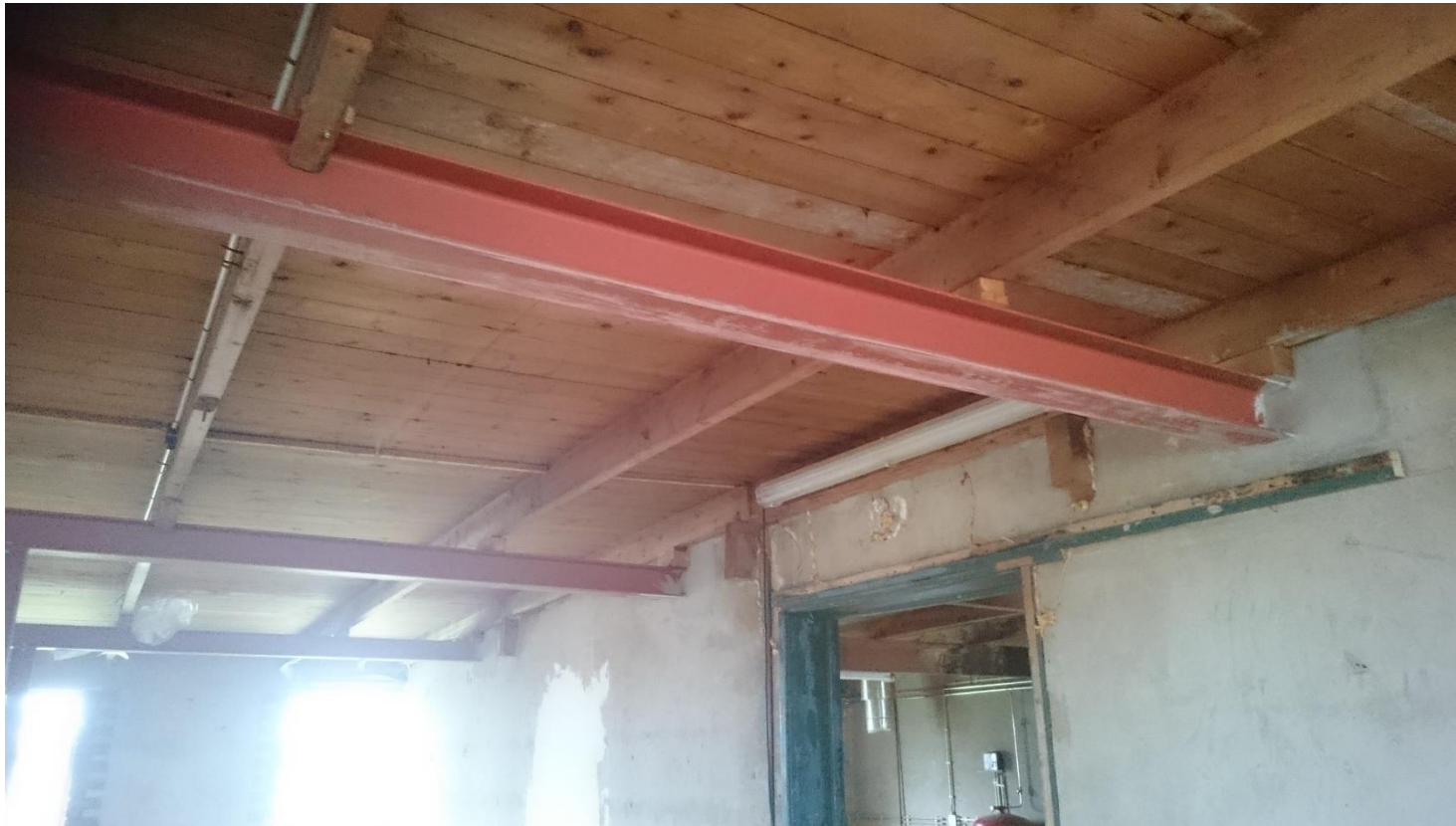
2 e verdieping Balklaag, stalen liggers en kolommen
