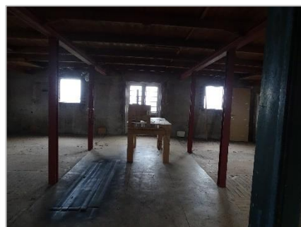
Foto 28: Bovenste etage waar appartementen gepland zijn.
