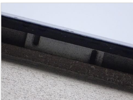
Foto 19: Gevel/dakrand oude bollenschuur (geen openingen, stoorvoegen, ventilatiegaten o.i.d.).
