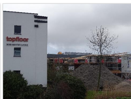
Foto 9: Plangebied (nieuwbouwproject in uitvoering aan noordoostzijde).
