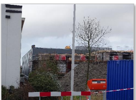
Foto 10: Plangebied (nieuwbouwproject in uitvoering aan noordoostzijde).
