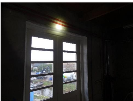
Foto 48: Geen openingen bij gevels/kozijnen.
