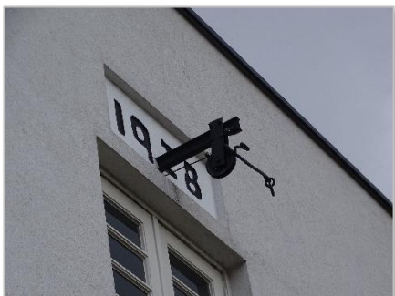
Foto 23: Gevel oude bollenschuur (geen openingen, bij ramen, deuren of kozijnen).
