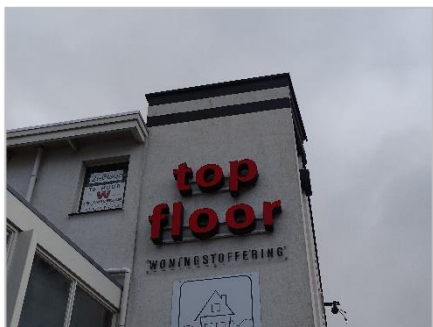
Foto 14: Gevel oude bollenschuur (in bovenste etage te realiseren appartementen).
