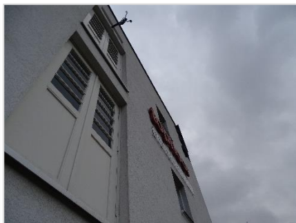
Foto 21: Gevel oude bollenschuur (geen openingen, bij ramen, deuren of kozijnen).
