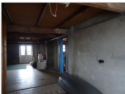
Foto 29: Bovenste etage waar appartementen gepland zijn.
