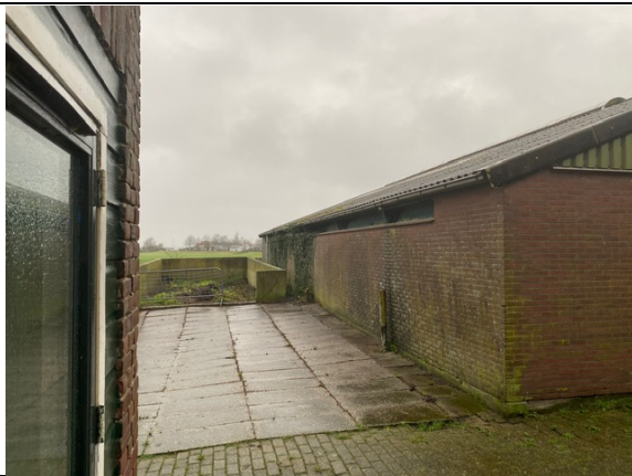
De nieuwe stal (rechts) De betonnen mestbak (midden)
