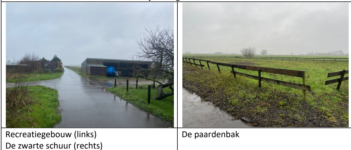
Foto's rondom het erf van de te verwijderen gebouwen:
