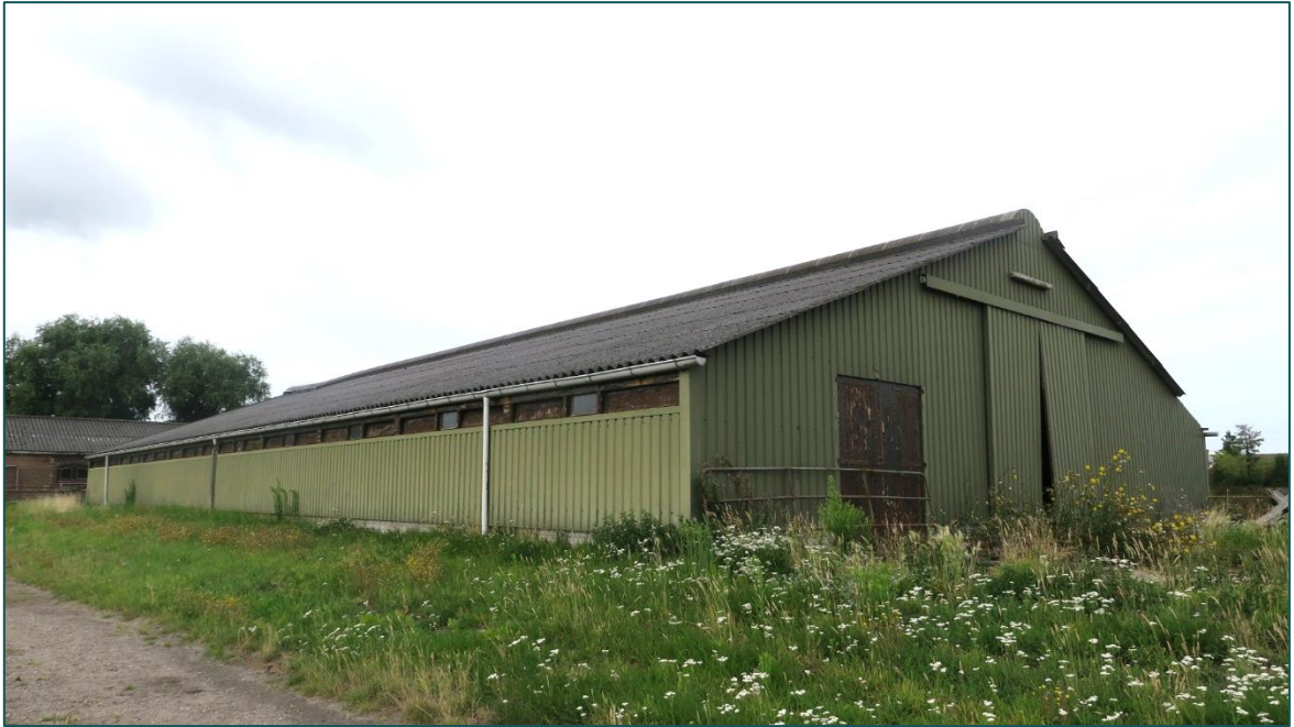
Figuur 7 De schuur (4) is opgetrokken uit damwandplaten en een golfplaten zadeldak.
