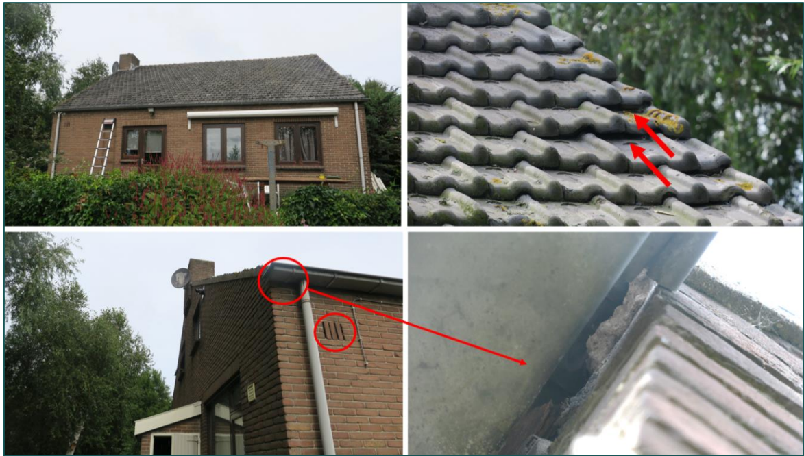
Figuur 3.1 De woning beschikt over meerdere openingen die vleermuizen toegang kunnen verlenen tot de spouwmuur of open dakruimte.
