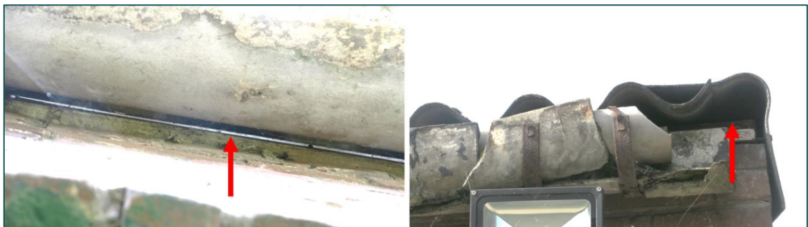
Figuur 3.2 De voormalige koeienstal beschikt over meerdere openingen die vleermuizen toegang kunnen verlenen tot de open dakruimte.
