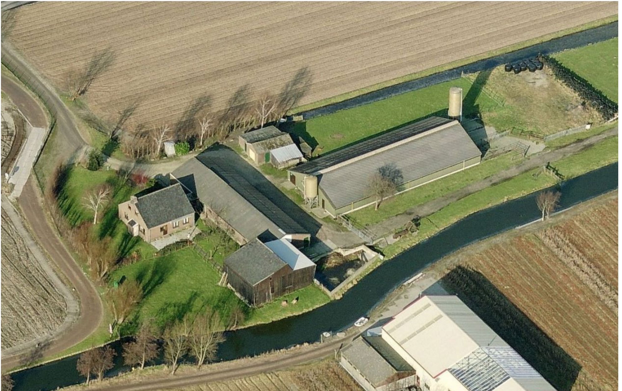
Zicht op plangebied vanuit de lucht in vogelvlucht zuidrichting (foto Bing Maps 3D)
