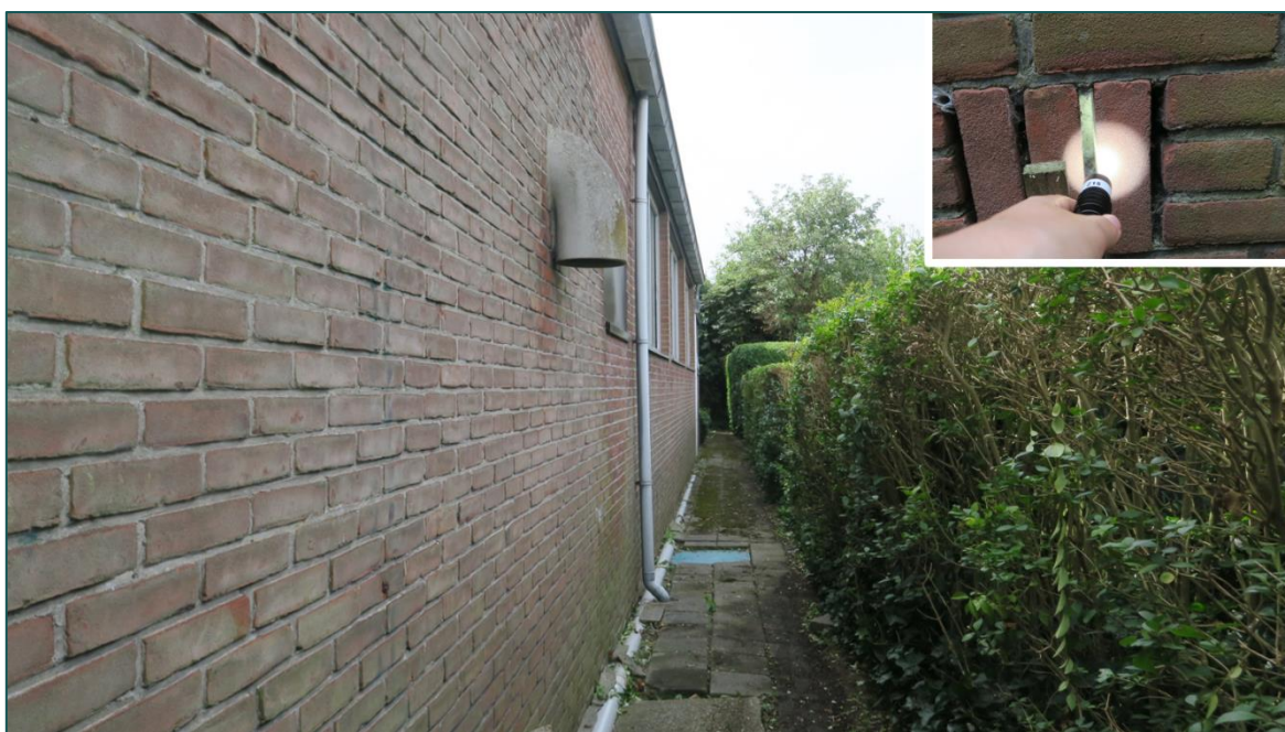
Figuur 6 De noordelijke gevel van de bedrijfshal is gesitueerd nabij een haag. De gevels van de bebouwing bevatten geen (geschikte) openingen welke kunnen dienen als invliegopeningen voor vleermuizen. Tevens is de spouwruimte opgevuld met isolatiemateriaal.
