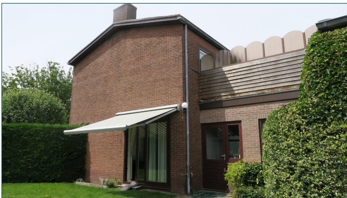
Figuur 2 De tuin bij de woning bestaat voornamelijk uit een goed onderhouden gazon. De gevels van de bebouwing bevatten geen (geschikte) openingen welke kunnen dienen als invliegopeningen voor vleermuizen. Tevens is de spouwruimte opgevuld met isolatiemateriaal. De woning blijft binnen de beoogde ruimtelijke ingreep behouden.
