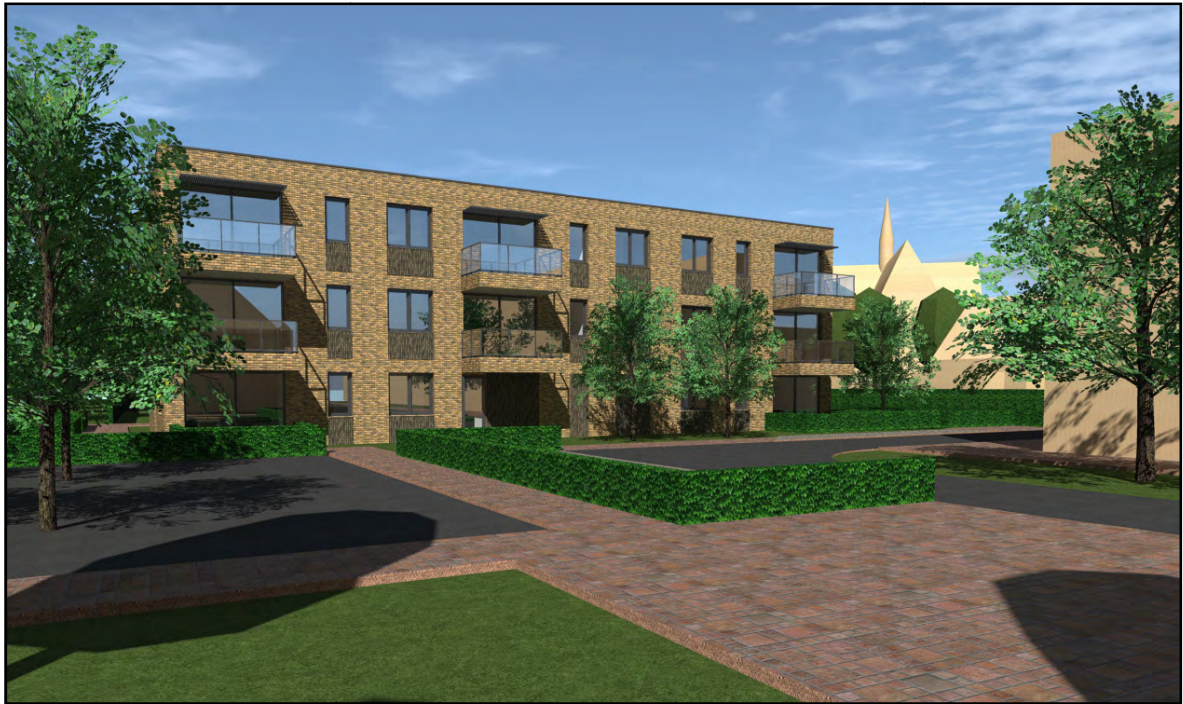
Figuur 1.2: Impressie appartementengebouw De Waaier
