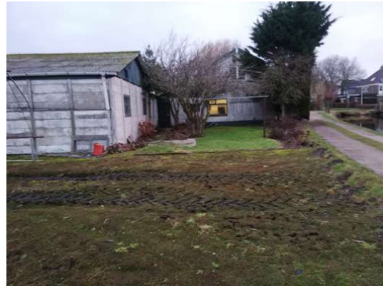
Afbeelding 10. Westzijde van de schuur en halfverhard pad
