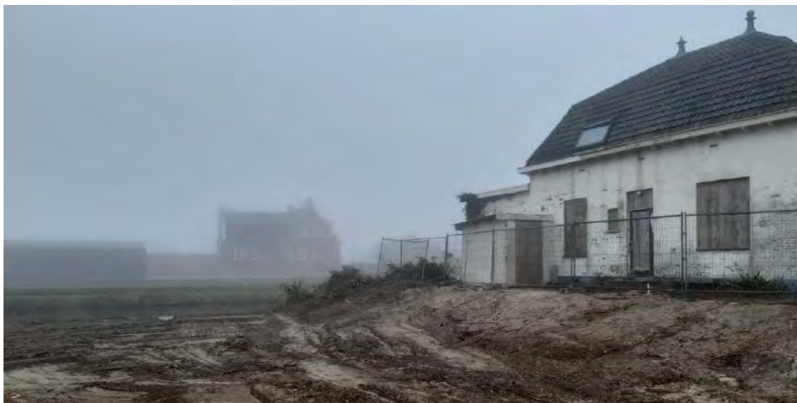
Figuur 3.3: Op deze foto, genomen achter de nog staande bebouwing aan Loosterweg 16, is goed te zien dat het maaiveld binnen het onderzoeksgebied een stuk lager ligt dan de grond rondom de bebouwing. De kijkrichting is het zuiden.
