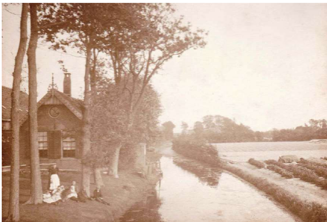
Figuur 2.11: Een foto waarop het erf van boerderij 'De Coehoorn' te zien is. Centraal ligt het Mallegat. Links van het zomerhuis is het dak van de oude boerderij te zien. Die werd in 1922 gesloopt (bron: Theo van der Salm).
