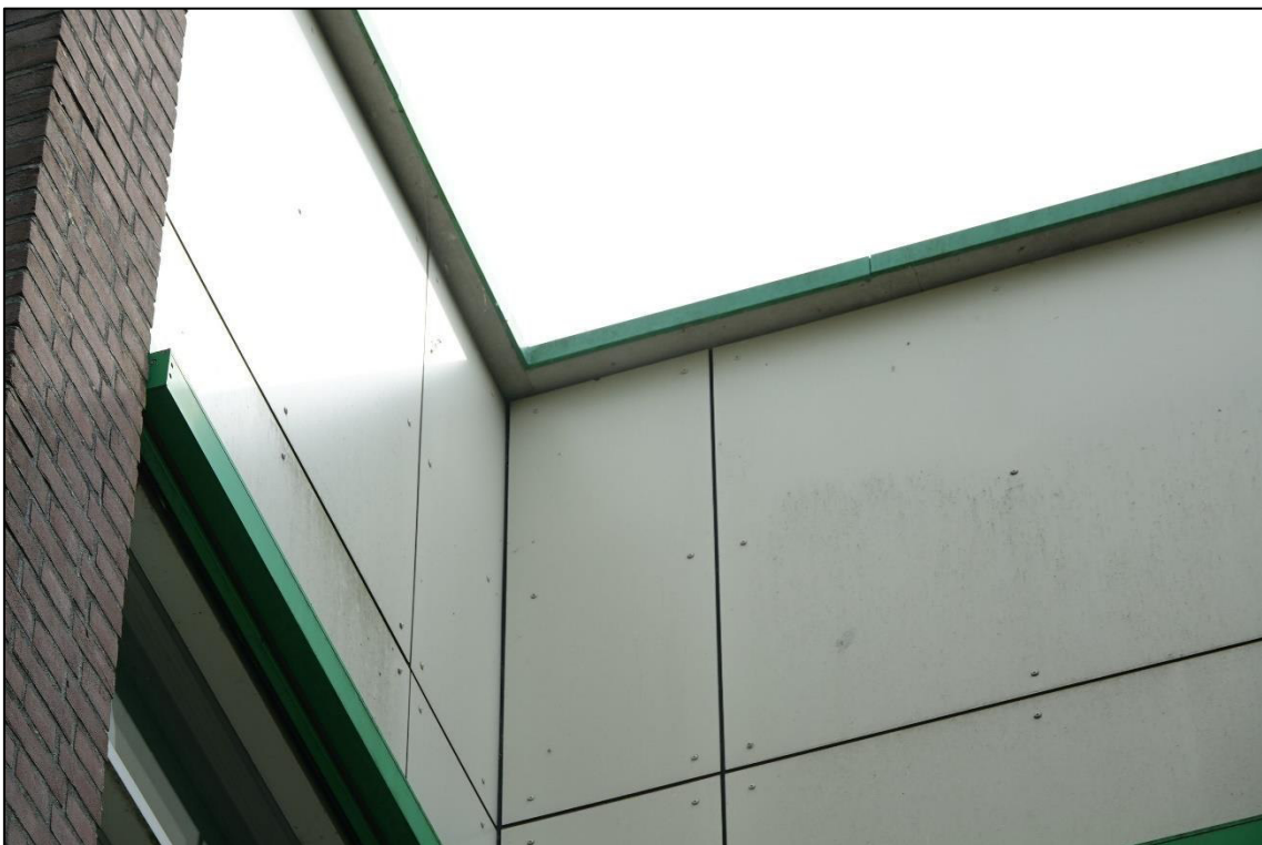
Figuur 10: Ruimte bij de kunststof platen waar dwergvleermuizen tussen kunnen kruipen.
