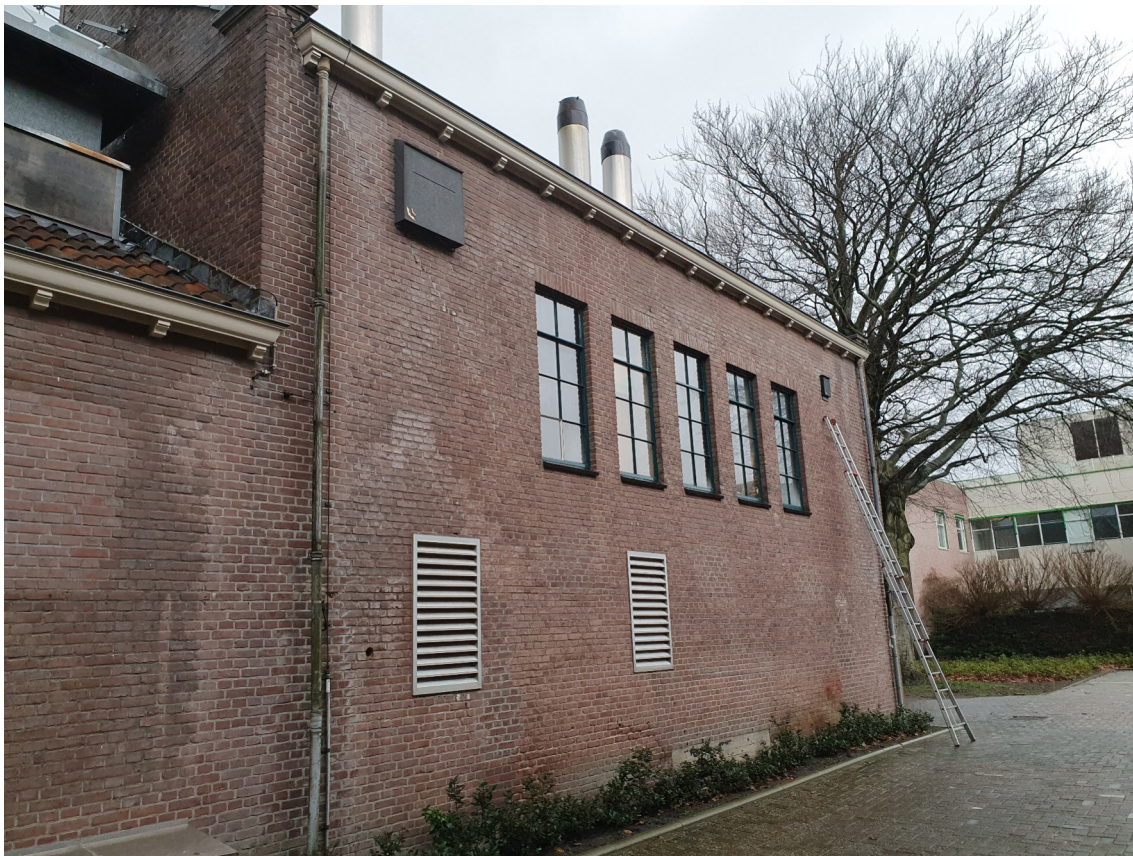
Figuur 8: Twee van de kasten die ter mitigatie zijn opgehangen aan de naastgelegen gebouwen. De grote kast is de kraamkast en de kleine kast is geschikt als paar en zomerverblijf (foto van 4 feb 2022).
