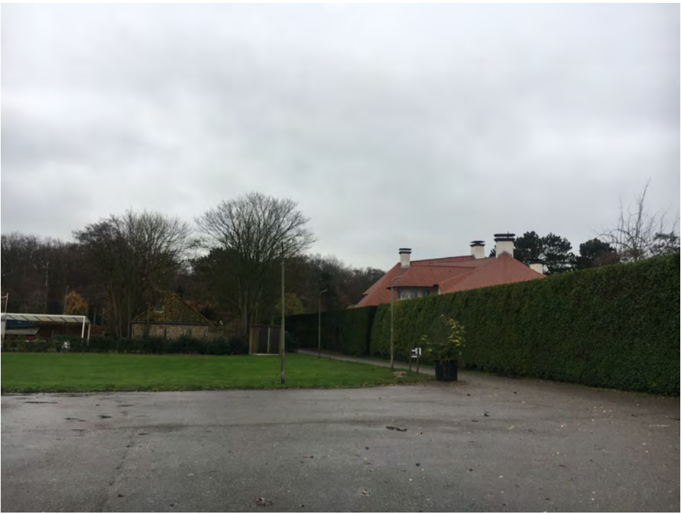
Zicht op achterzijde van bebouwing aan Herenweg.
