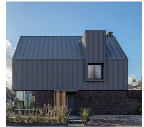
Dakbedekkingen in gedekte kleuren
