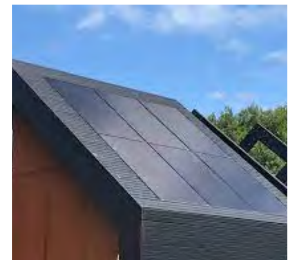
Zonnepanelen geïntegreerd in het dak
