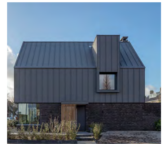
Dakbedekkingen in gedekte kleuren
