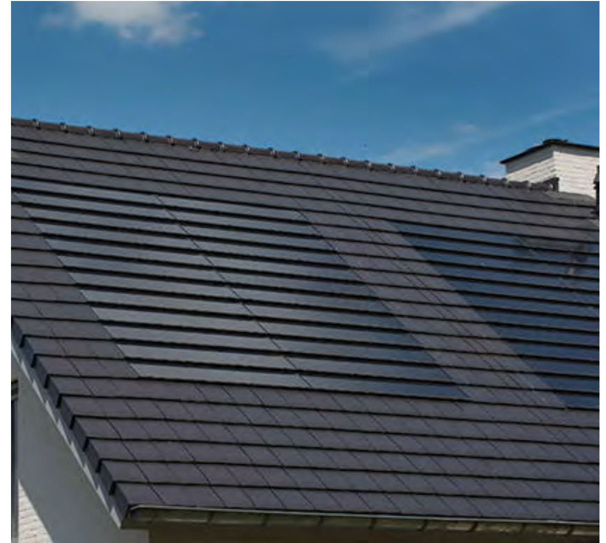
Zonnepanelen worden geïntegreerd in het dakvlak
