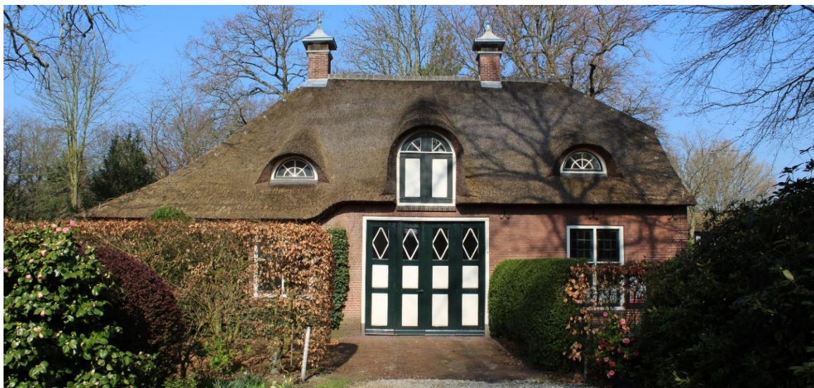
Figuur 11: De linker zijgevel van het dienstgebouw.
