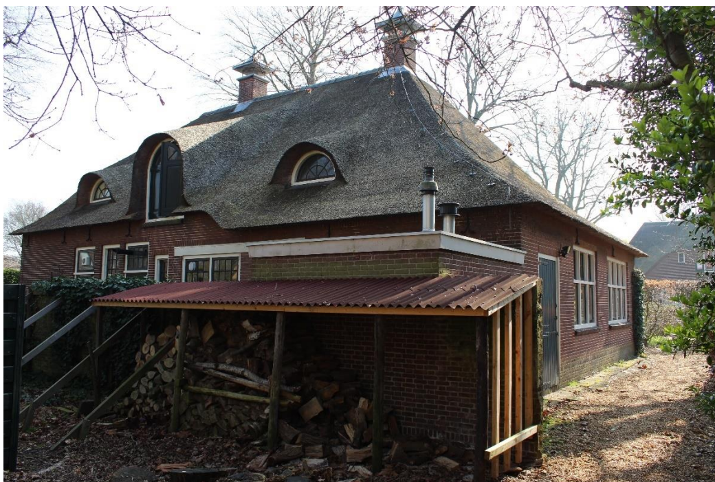
Figuur 15: De achtergevel ten tijde van het bouwhistorisch onderzoek.
