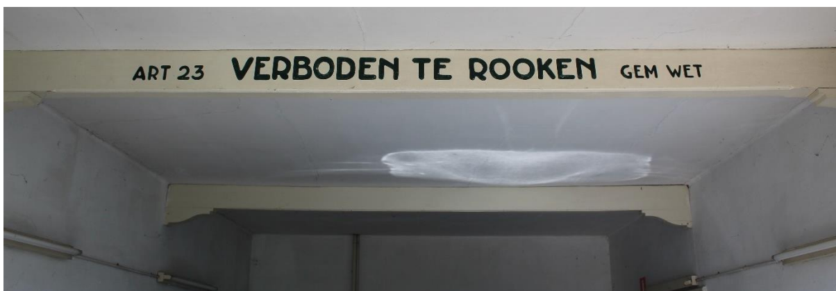
Figuur 18: Opname van de balken die zichtbaar zijn in de garage.
