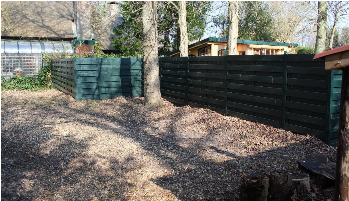
Figuur 24: Opname van de tuin grenzend aan het dienstgebouw, gezien naar de rechter belending.
