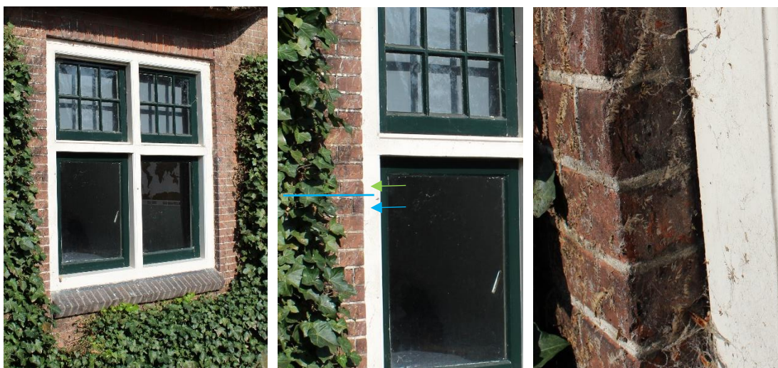
Figuur 12: Links: het venster links van de garage-entree, midden: de overgang van het oorspronkelijke metselwerk en het verzaagde werk, rechts: de zaagsporen bij de linker vensterdagkant.
