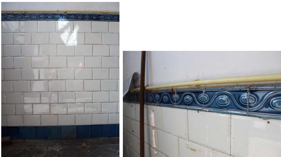
Figuur 17: De oorspronkelijke tegelafwerking in de garage. In de gang van de paardenstal was eenzelfde afwerking aanwezig. Deze is nog deels aanwezig, tegen de linker gangmuur.
