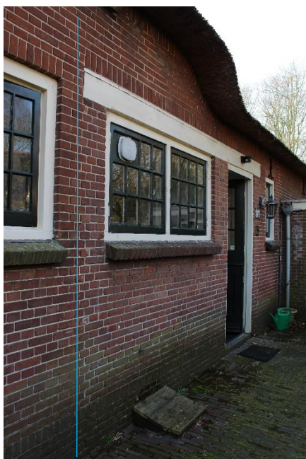
Figuur 14: De blauwe lijn markeert de, nauwelijks zichtbare, overgang tussen het oorspronkelijke metselwerk (links) en de doorzetting van de gevel uit 1949. Recht een uitsnede uit de ontwerptekening. (Bron: ELO)
