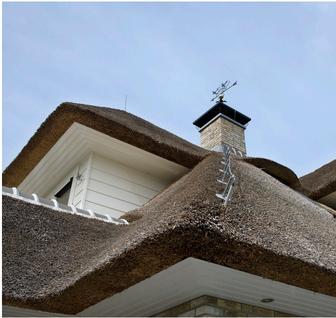
Samengestelde rieten kap
