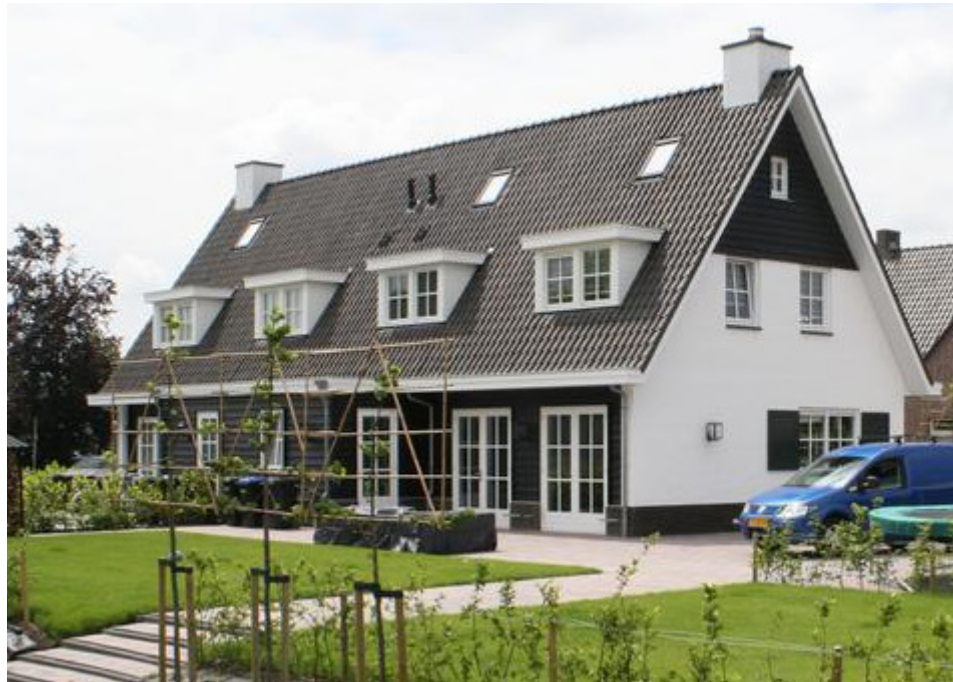
stucwerk afgewisseld met houten delen
