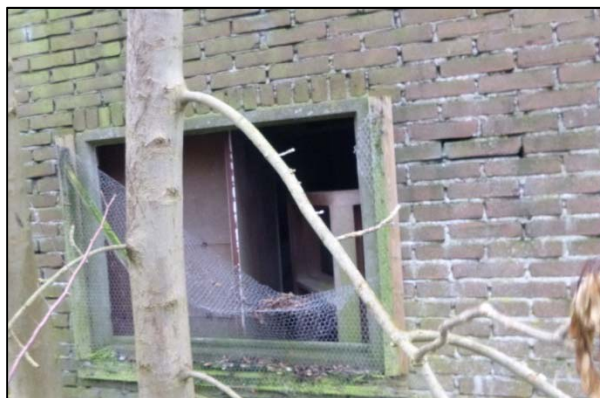
Foto: zijkant grote opslagschuur (stenen gebouw links)
