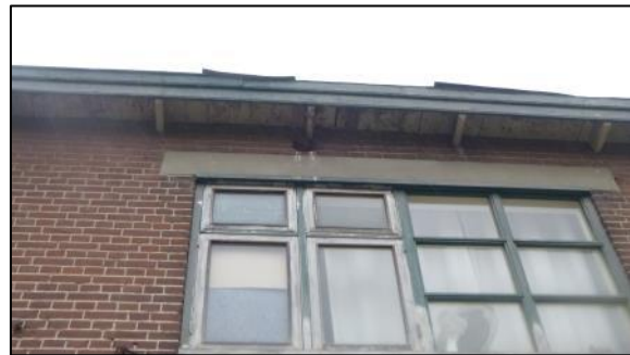
Gat in muur met sporen van (vogel)uitwerpselen
