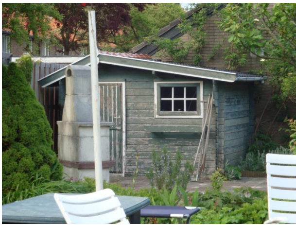
tuinhuisje (noordwest hoek plangebied, achterzijde woningen Rusthofflaan en Apollastraat)
