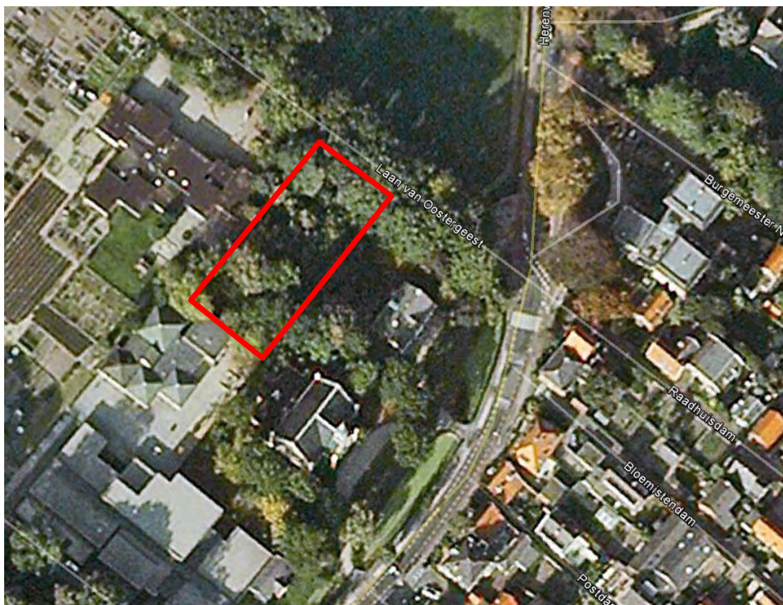
Luchtfoto huidige situatie
