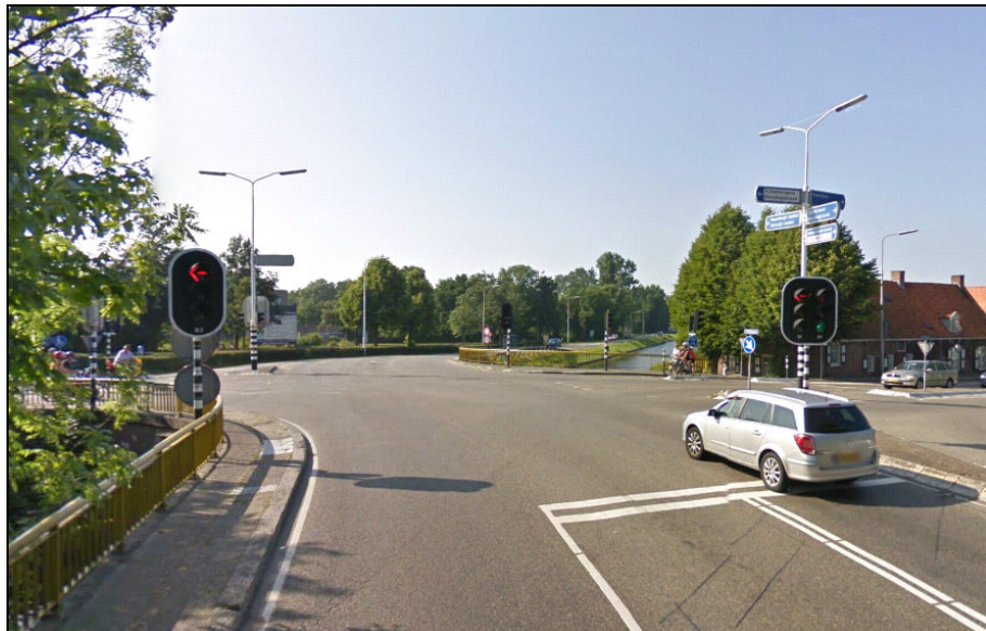
Figuur 1.1: Zicht op de Nagelbrug bij Voorhout (Bron: GoogleMaps)
