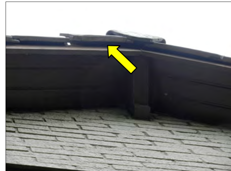
Figuur 5: De kieren tussen de kantdakpannen van het woonhuis zijn toegankelijk voor vleermuizen om naar de ruimte onder de dakpannen te kruipen.
