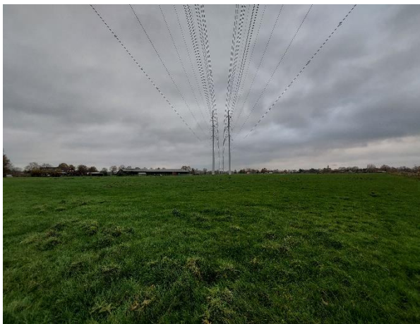
Afbeelding 5. Hoogspanningsleidingen van west naar oost.
