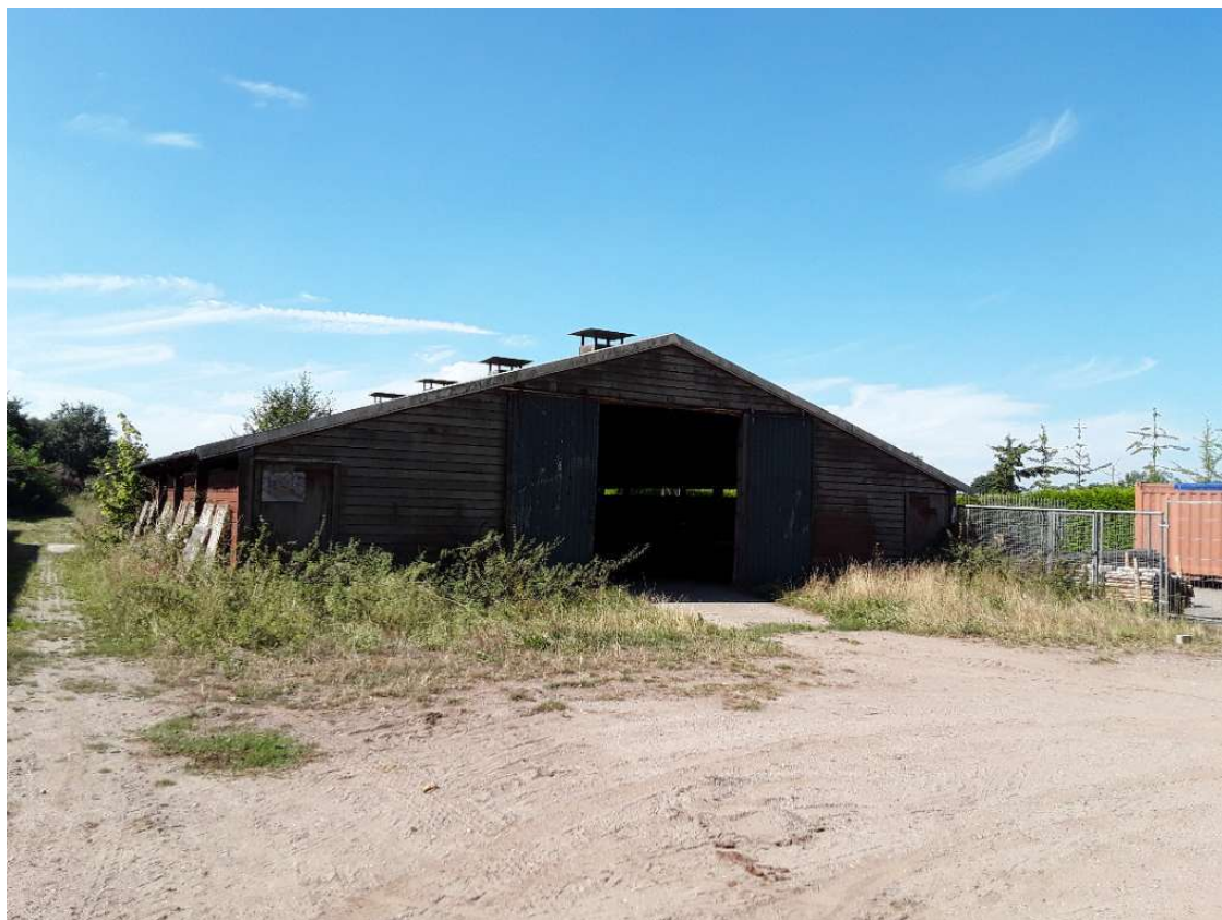
Schuur (boven vloerpeil) aan de Plantenweg 6 te Voorst
