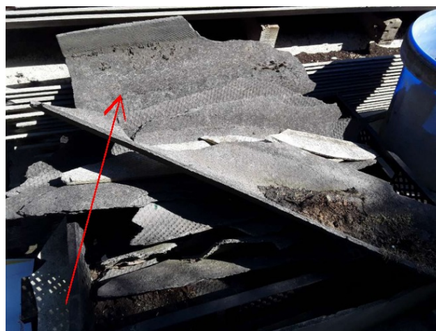
Golfplaten losliggend in een krat naast de schuur.
