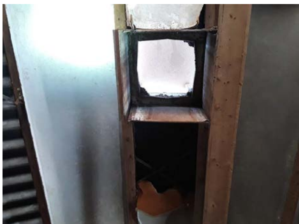
Vlakke platen op kokers van dupanel.
