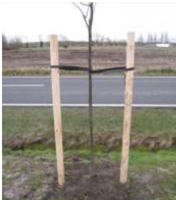
Voorbeeld van een solitaire boom, voorzien van twee boompalen en boomband.
