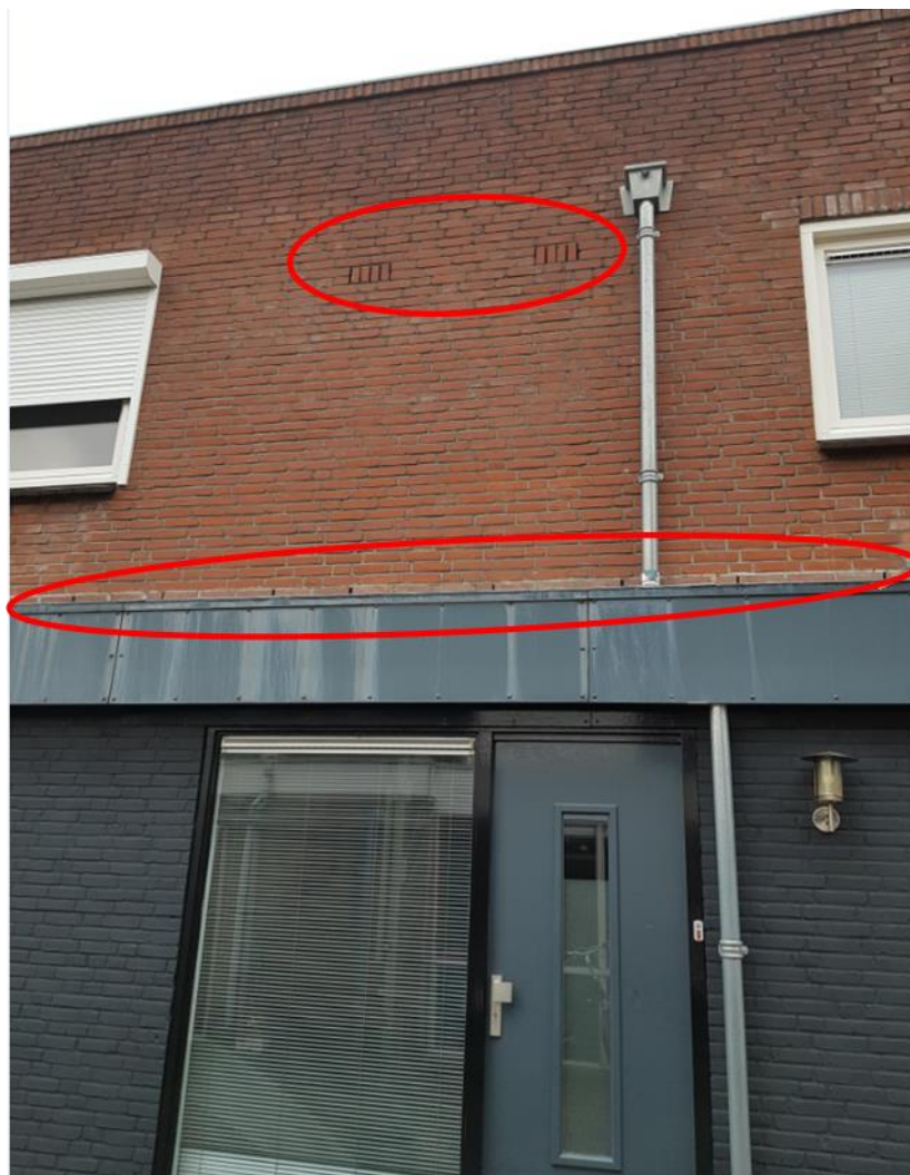
Figuur 5. Geschikte openingen voor vleermuizen in het appartement. Er zijn open stootvoegen en ventilatieopeningen te zien in het bovenste deel van de muur (rood omcirkeld).
