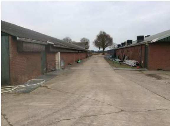
Figuur 14: Overzichtsfoto bebouwing
