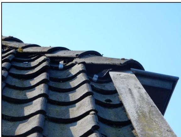
Figuur 10. Gedetailleerder beeld van het vogelschroot bevestigd onder de nokpannen.
