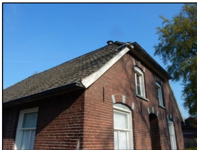
Figuur 3. Woonhuis gelegen op het zuidelijke deel van de onderzoekslocatie.
